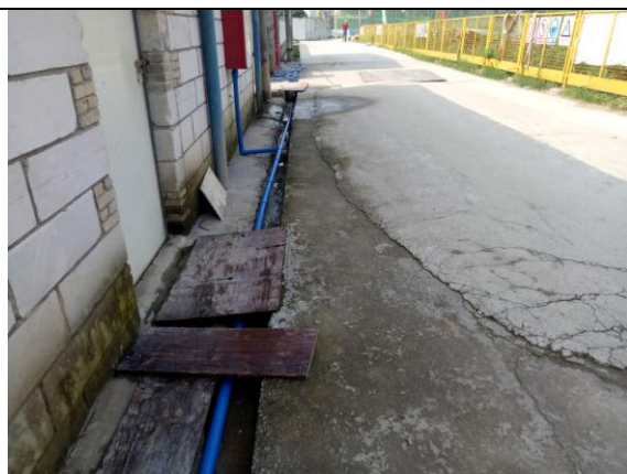
施工临建区沉沙池 (2019.06)
